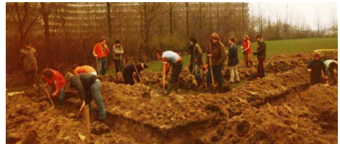
Graafwerk voor de fundering (collectie Groen-Geel).
