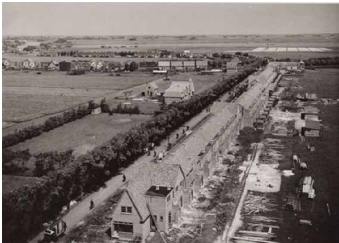
De woningblokken rechts in aanbouw, circa 1928. Het Wormerlaantje, later Nieuweweg is eerst een smalle verbindingsweg van ongeveer vier meter breed met aan weerszijde een bomenrij. Het werd in 1889 aangelegd door de gemeente Wormerveer, gelijk met de Zaanbrug. De weg is in 1937 door Wormer overgenomen en verbreed. Links het sportveld van o.a. de Wormerveerse voetbalverenigingen WFC. en Q.S.C., later korfbalveld van 'Groen-Geel', de cirkels rond de palen zijn duidelijk zichtbaar (Waterlands Archief, WAT002000076).
